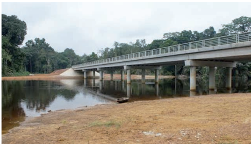
Un pont que relie le Gabon et la Guinée Equatoriale – exemple à multiplier dans la sous-région
