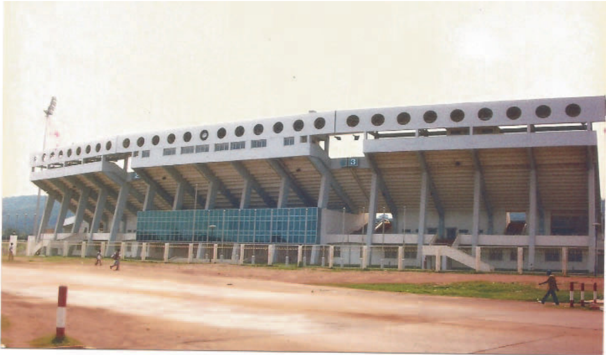
Photo 1 : Les acquis de l'expropriation : le Stade 20.000 Places à Bangui.
