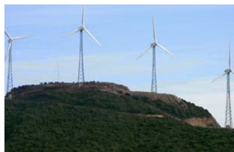
Par éolien au Nord du Maroc (Koudia Al Baïda)
