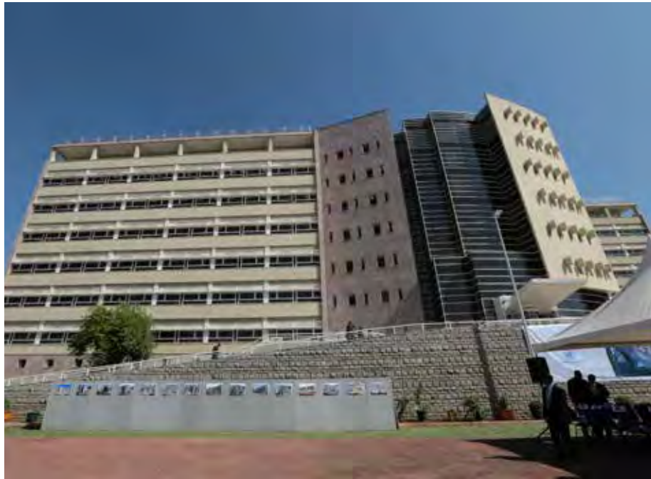
Vue du nouvel immeuble de bureaux dans l'enceinte de la CEA, octobre 2014. Photo © CEA
