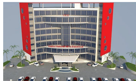
Vue de face en profil de l'immeuble siège de l'INS (en cours de construction)
